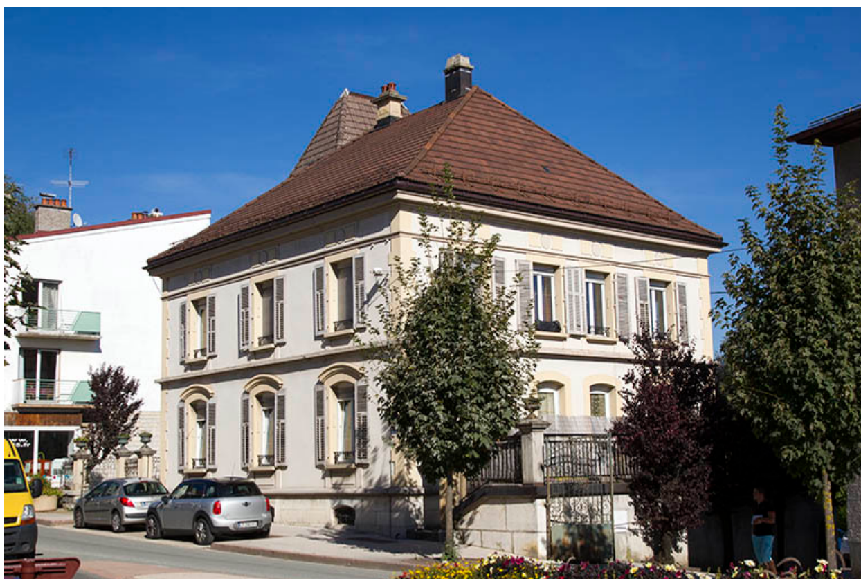
Façades antérieure et latérale droite.
