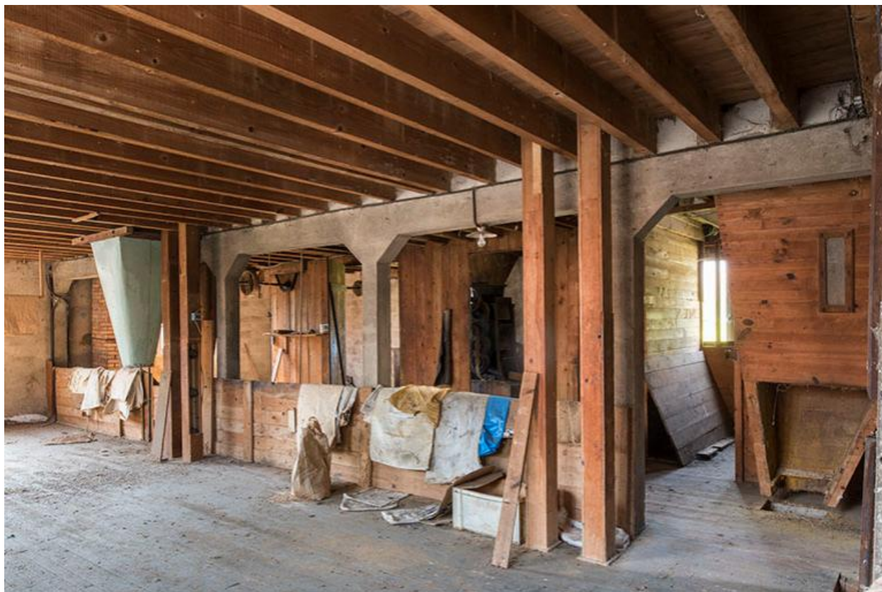
Vue d'ensemble du premier étage
