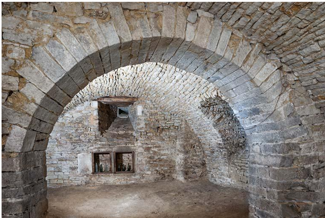
Vue générale de la cave
