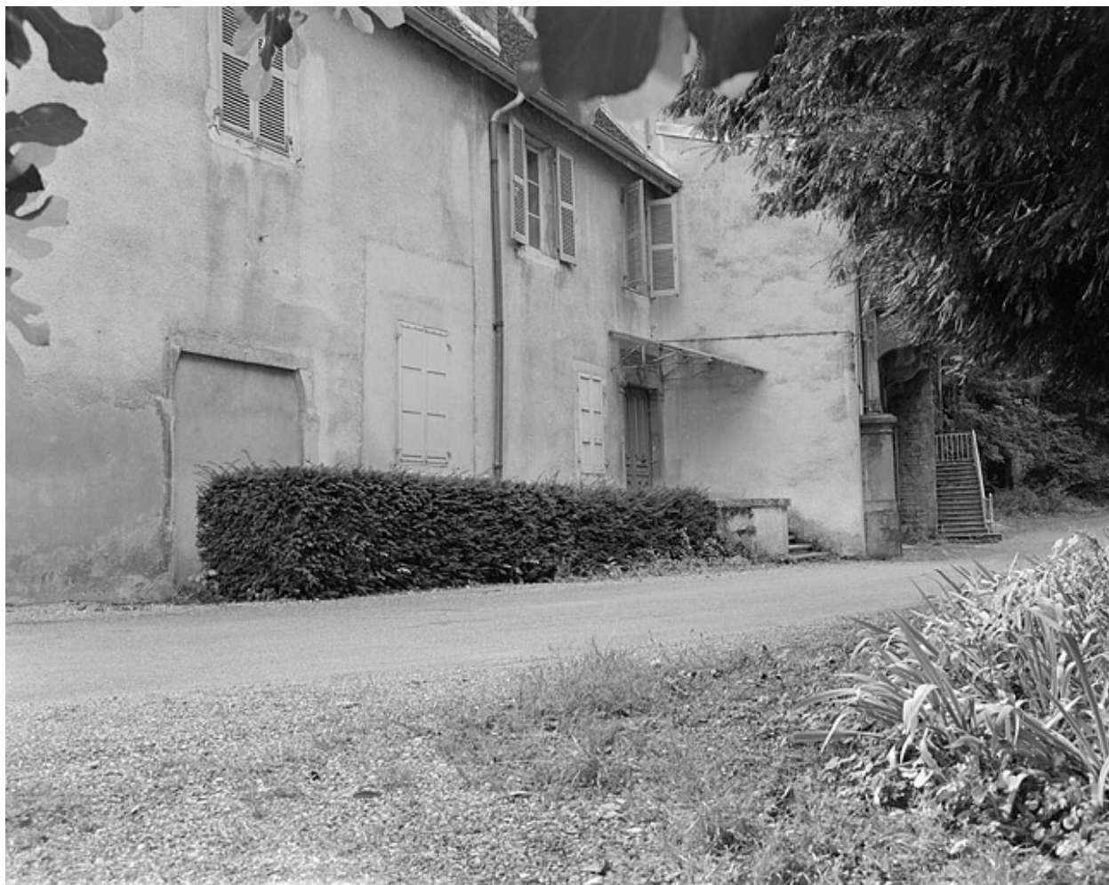
Façade latérale droite du bâtiment A.
