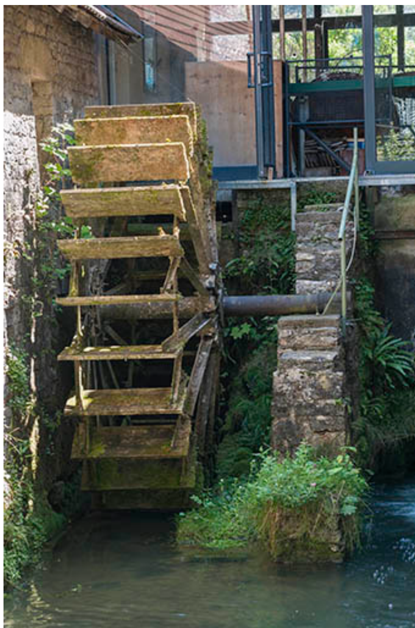
La roue hydraulique en-dessous.
