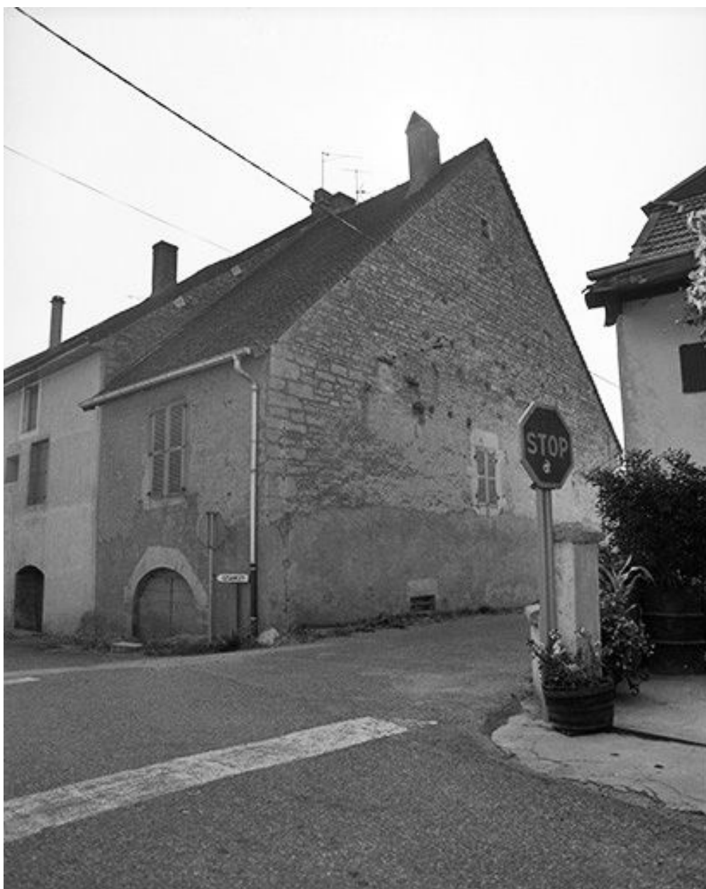
Face postérieure et pignon gauche.
