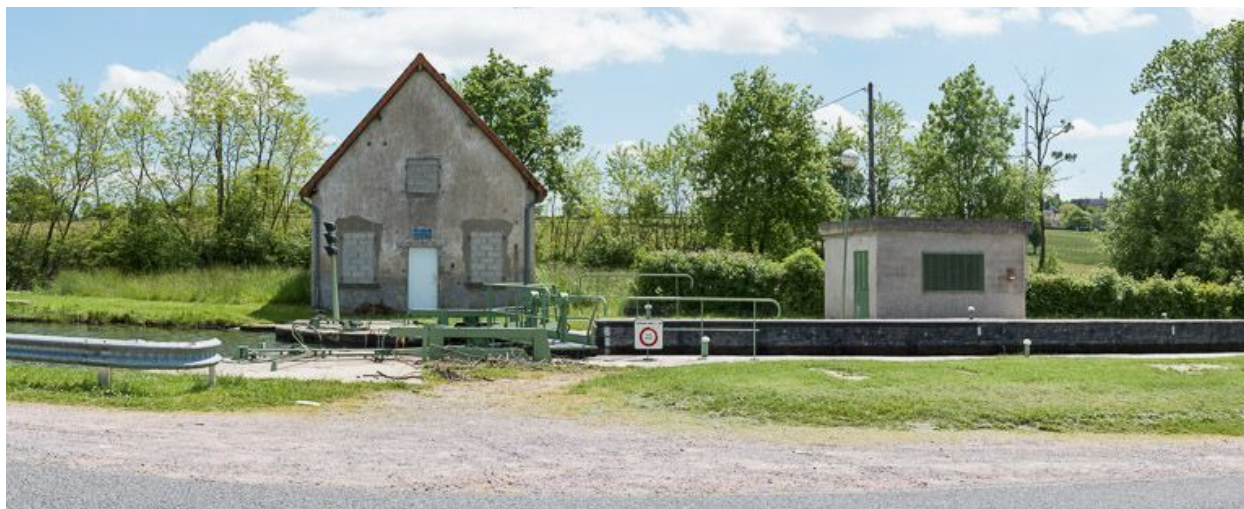
Vue de face de la maison éclusière.
