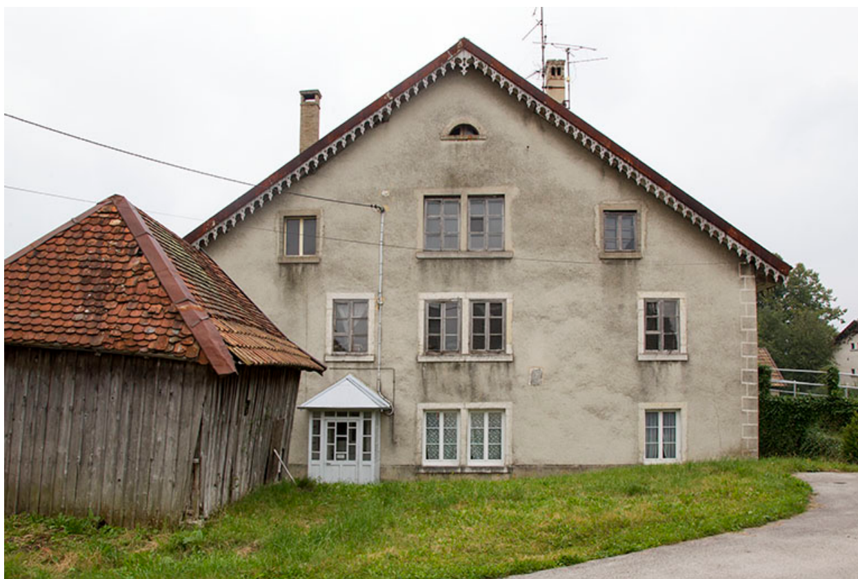
Façade latérale droite.
