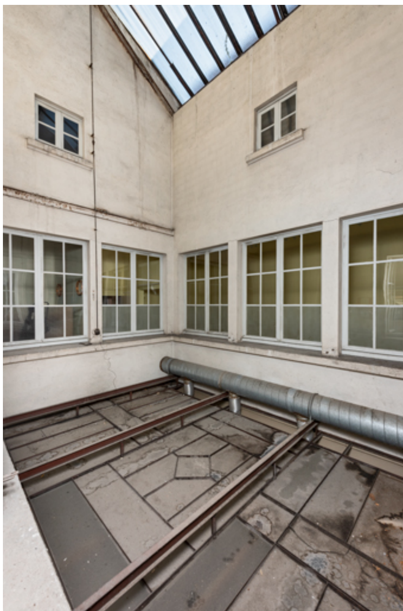
Puits de lumière au 1er étage.
