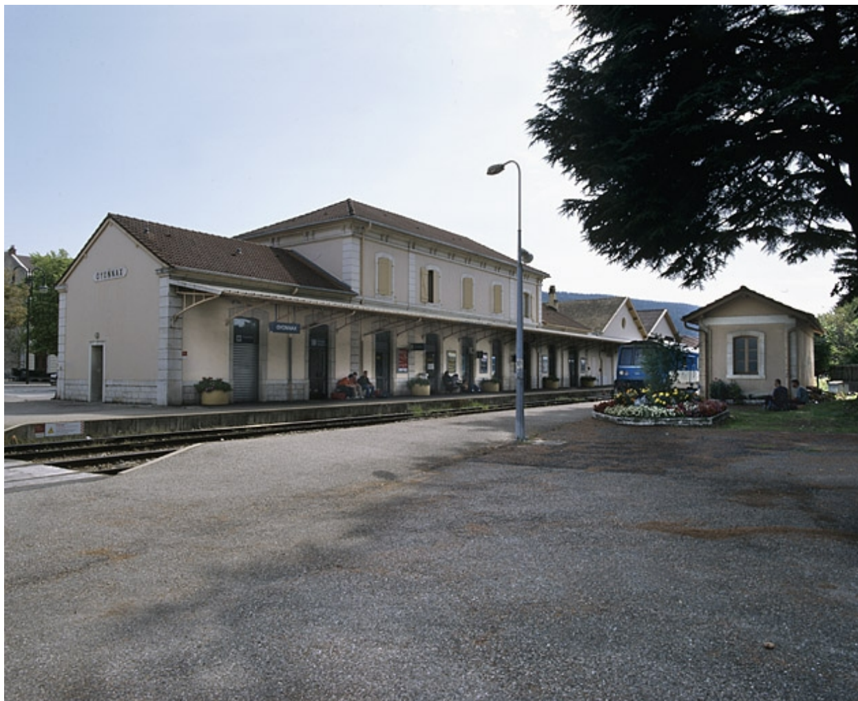
Vue d'ensemble, depuis le nord-ouest (côté Andelot-en-Montagne).
