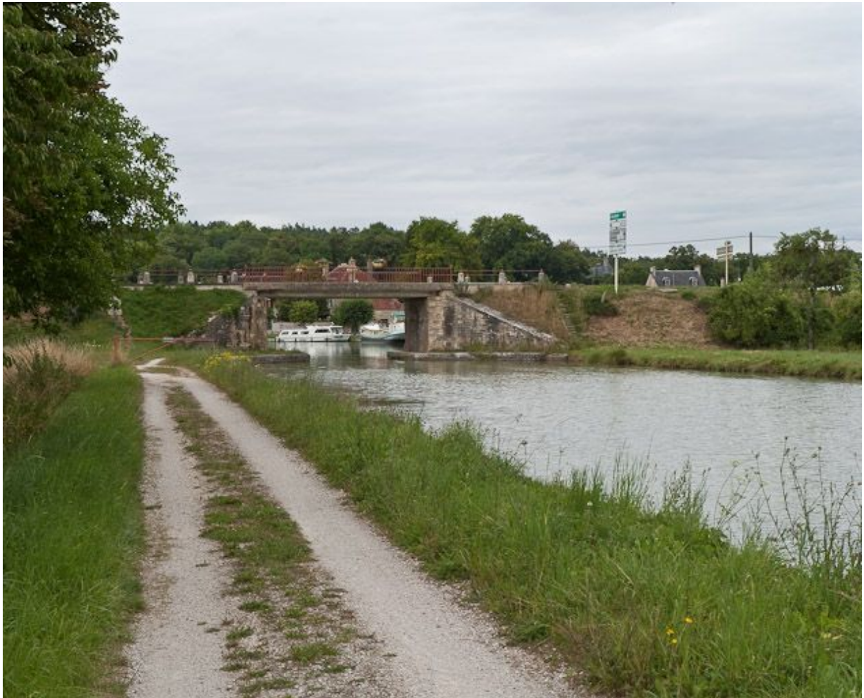
Vue du pont depuis l'amont.
