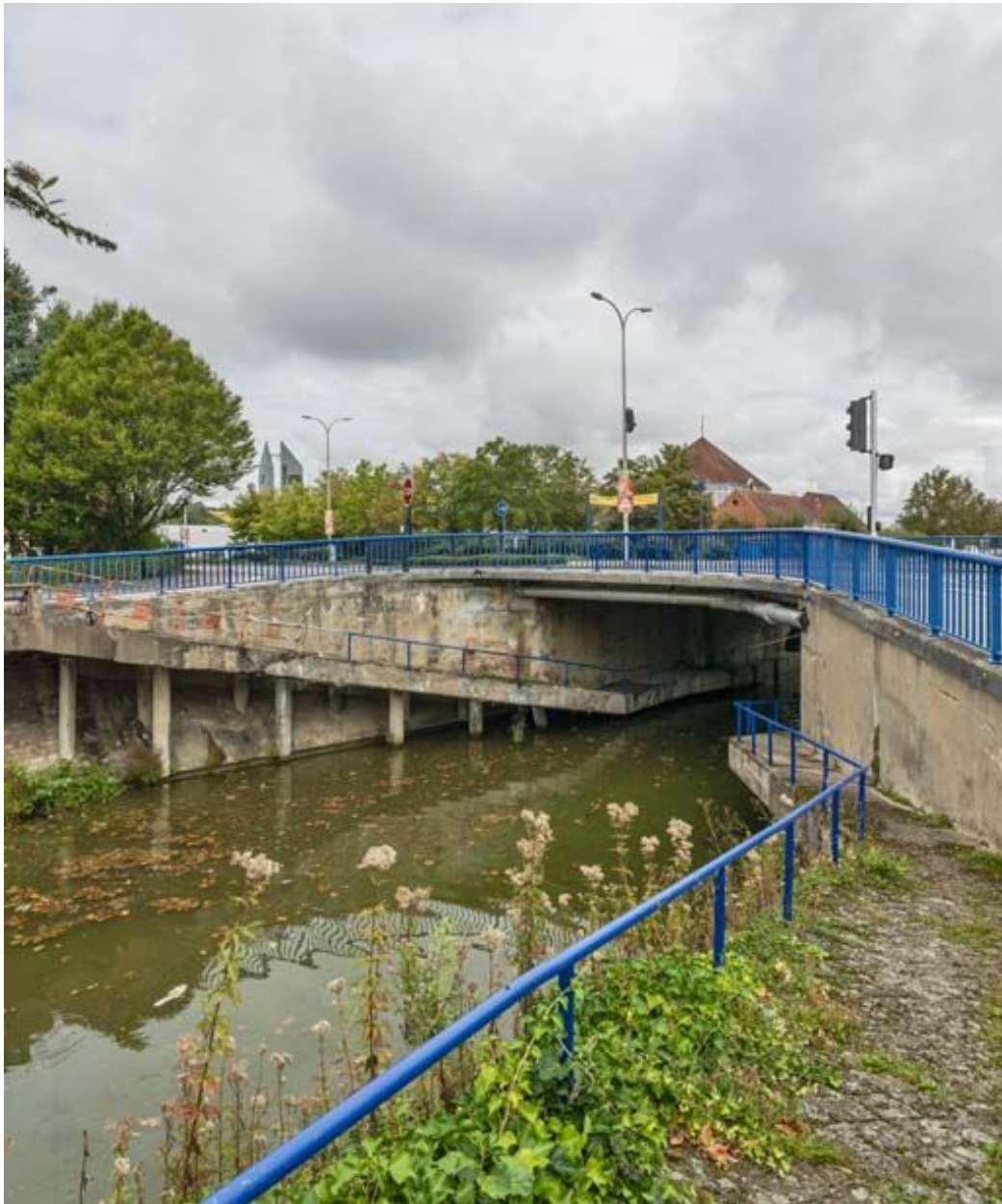
Vue d'ensemble du pont.
