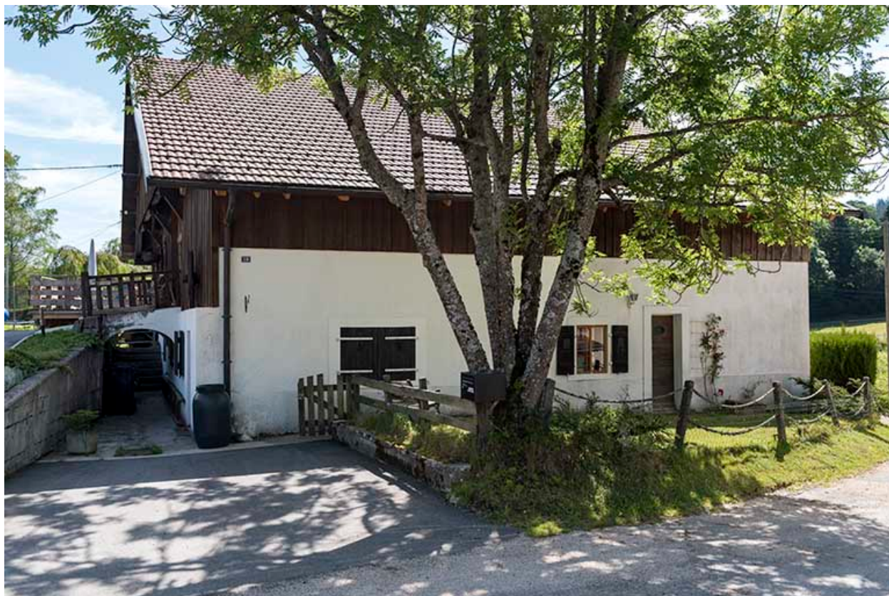
Façade latérale gauche et pont de grange.
