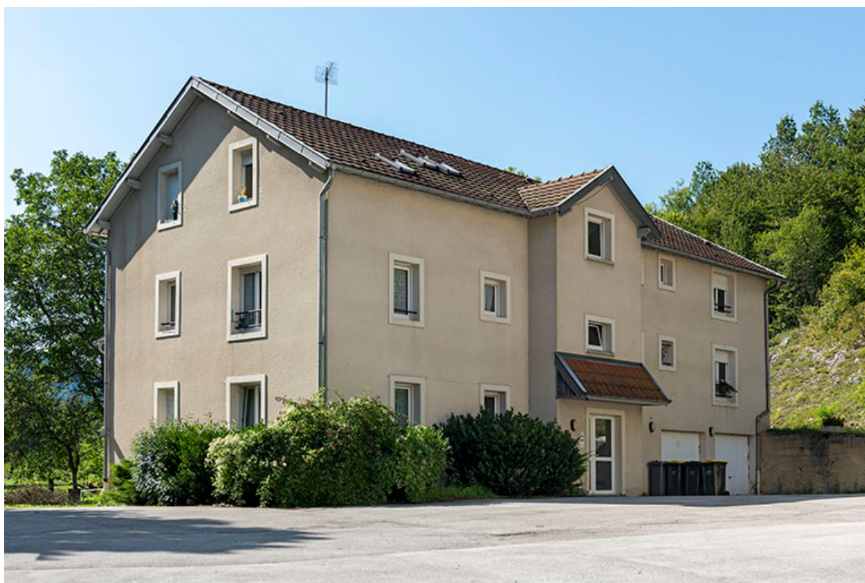
Maison : façades antérieure et latérale gauche.
