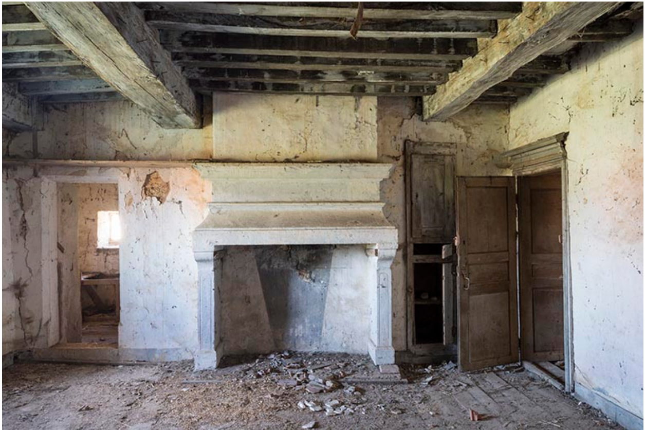
Cheminée de la chambre, logis 16e siècle.
