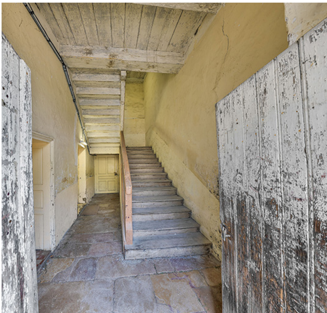
Caserne Vauban : cage d'escalier au rez-de-chaussée.
