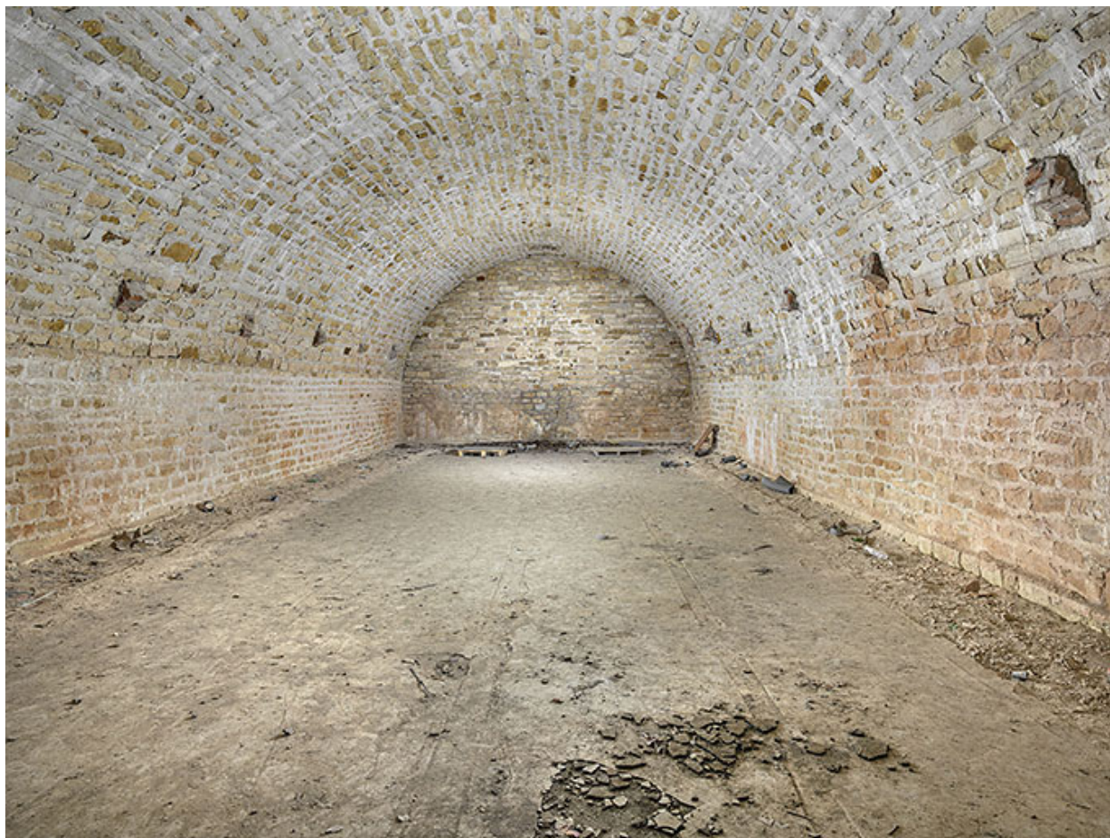
Magasin à poudre : vue d'ensemble.
