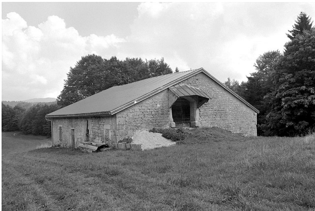
Face sud-ouest et façade postérieure.
