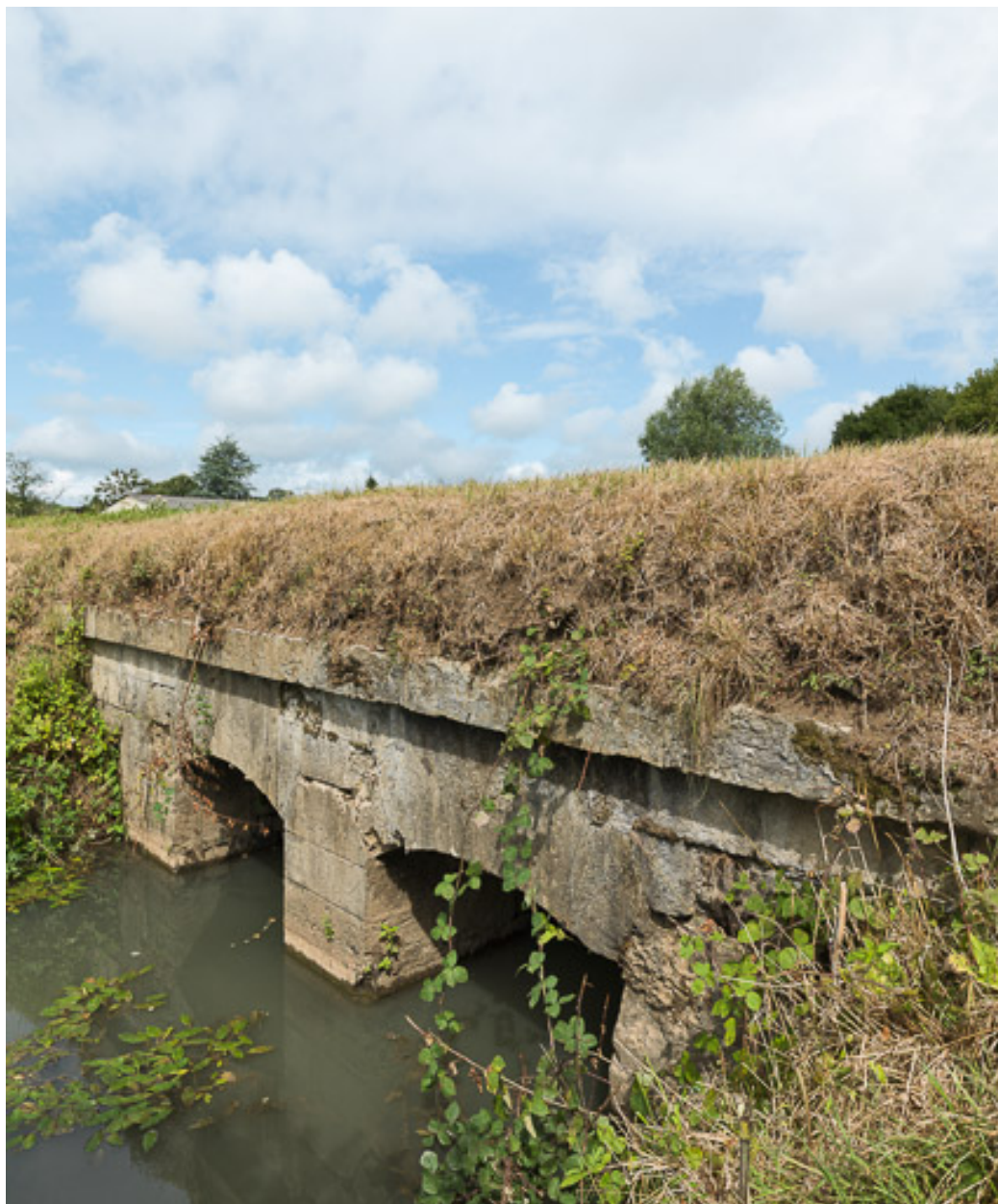
Vue de l'aqueduc.
