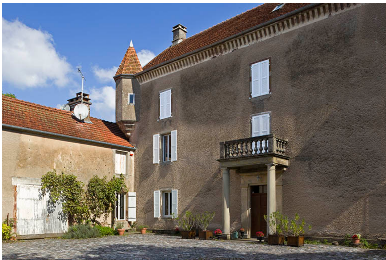
La cour, façade postérieure.
