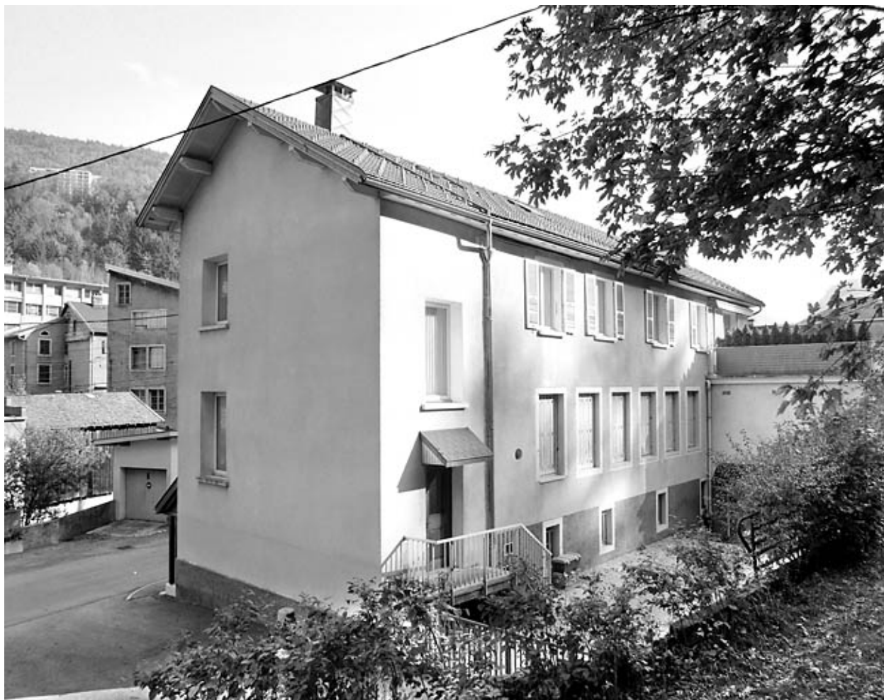
Elévation postérieure, de trois quarts gauche.
