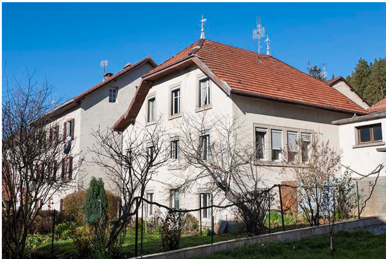
Façades postérieure et latérale gauche.
