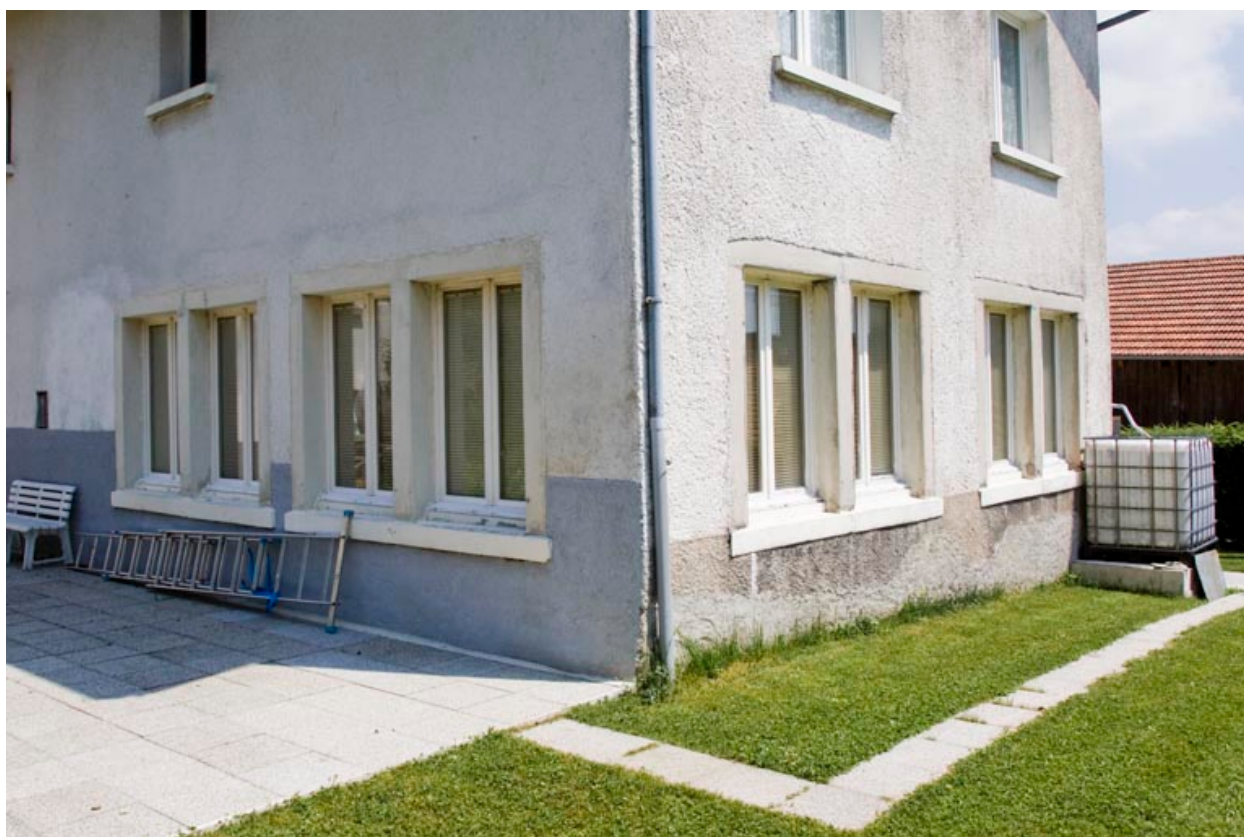
Fenêtres de l'atelier.
