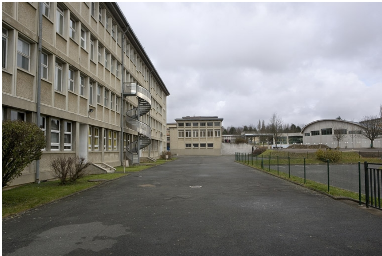
Vue latérale façade antérieure bâtiment D.
