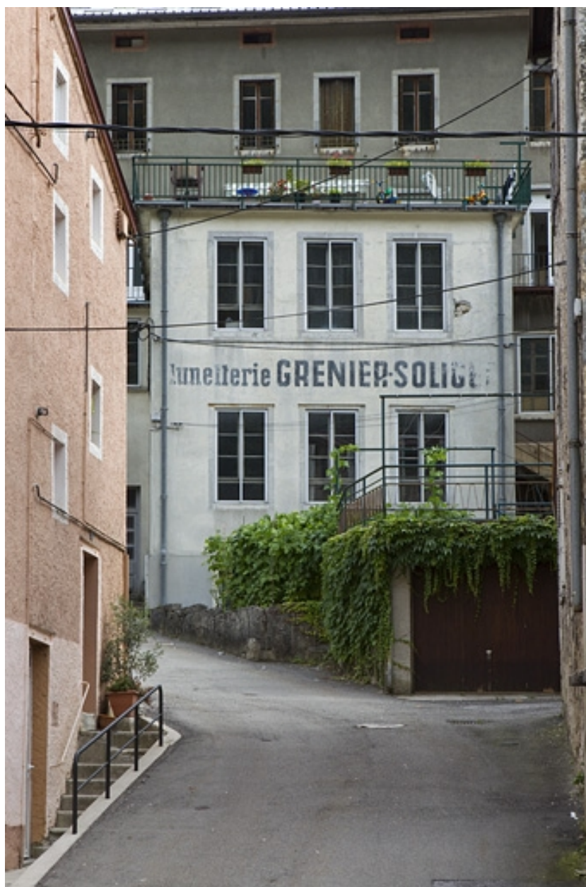
Façade postérieure sur la rue Fenandre.
