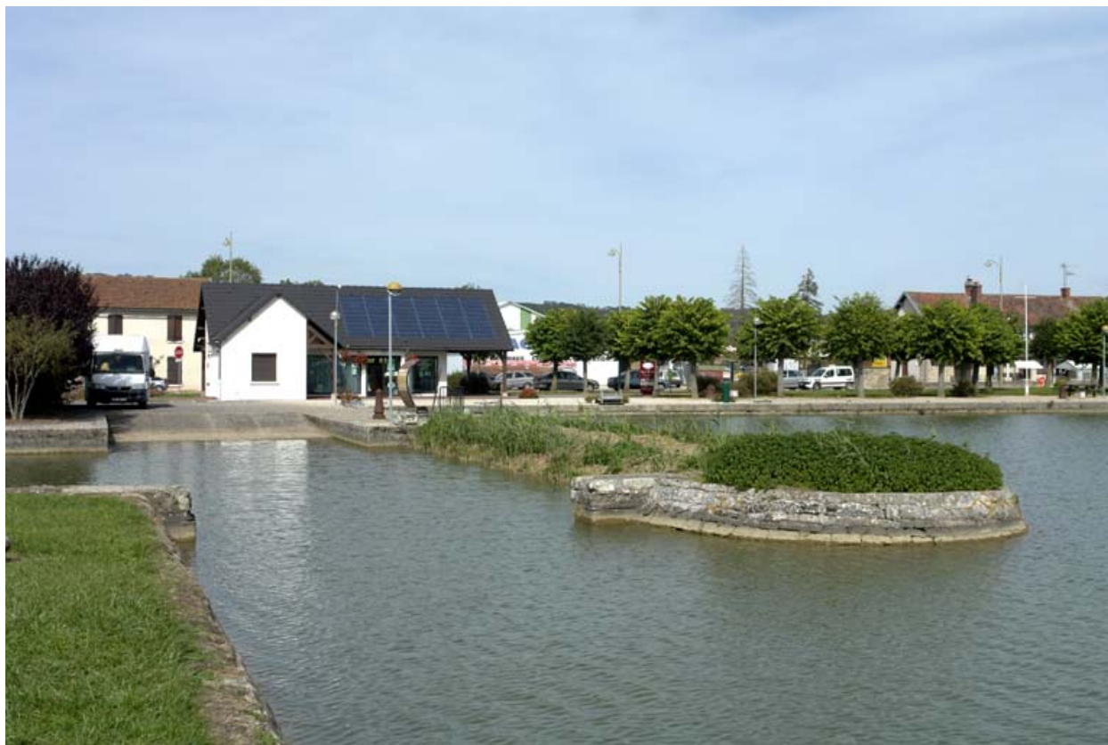
Cale à l'ouest du port, vue d'ensemble.
