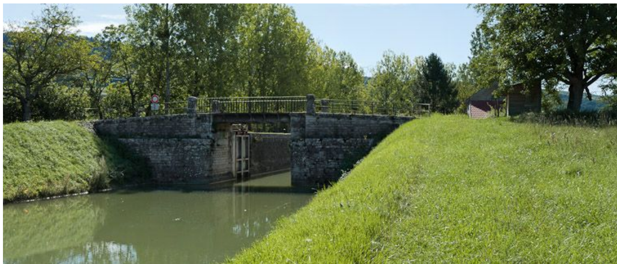
Vue du pont depuis l'aval.
