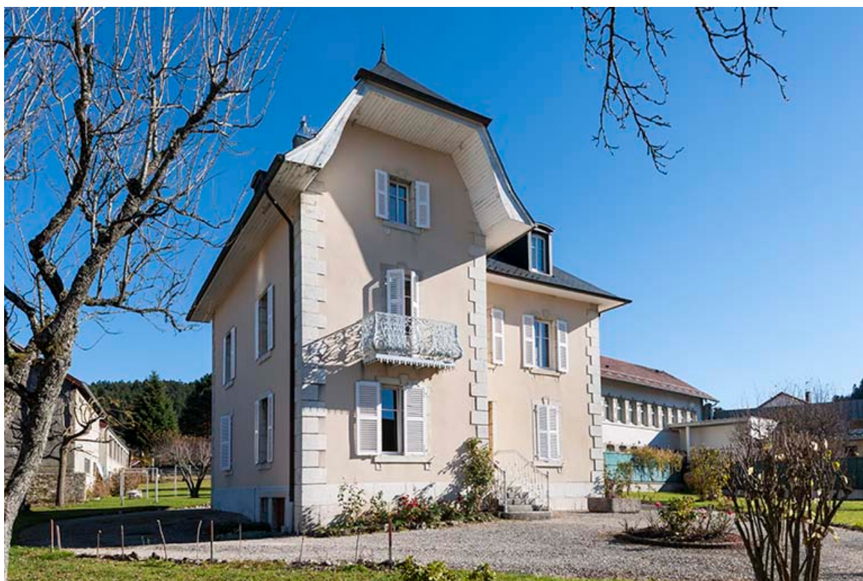
Logement patronal : façades antérieure et latérale gauche.
