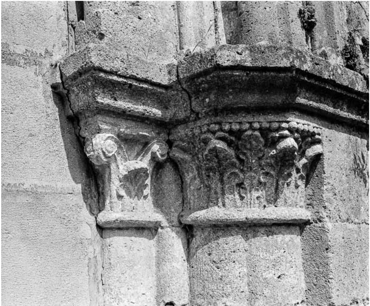
Détail : chapiteaux droits du porche.
