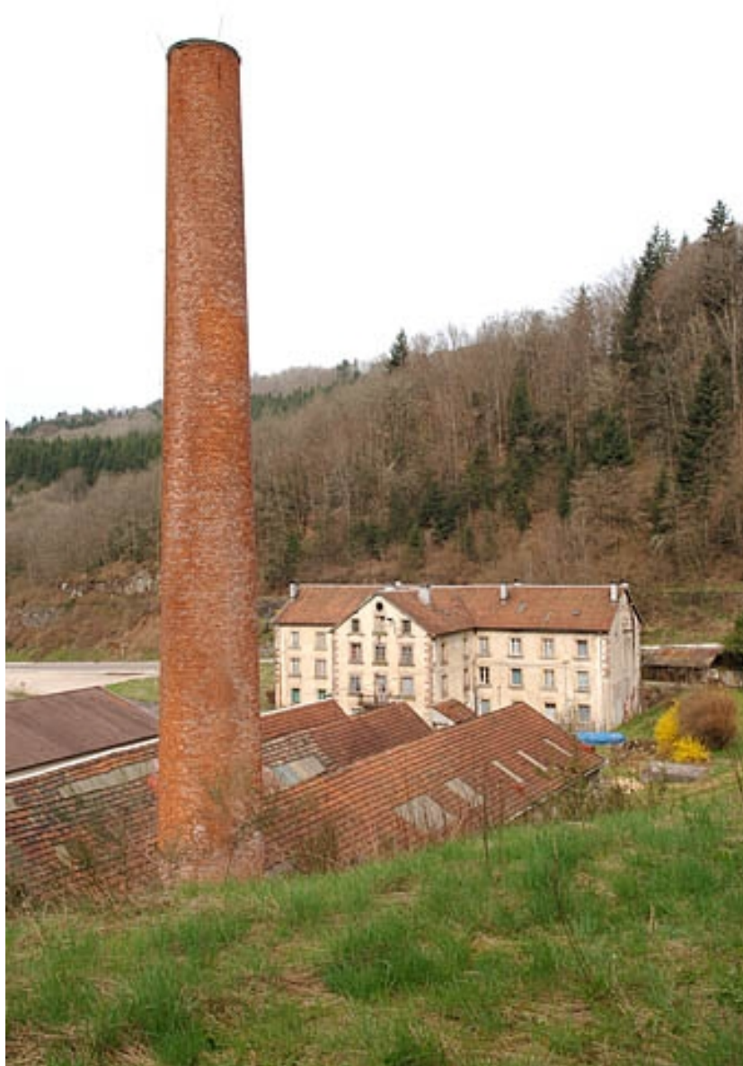
Vue plongeante depuis le nord-est (cadrage vertical).
