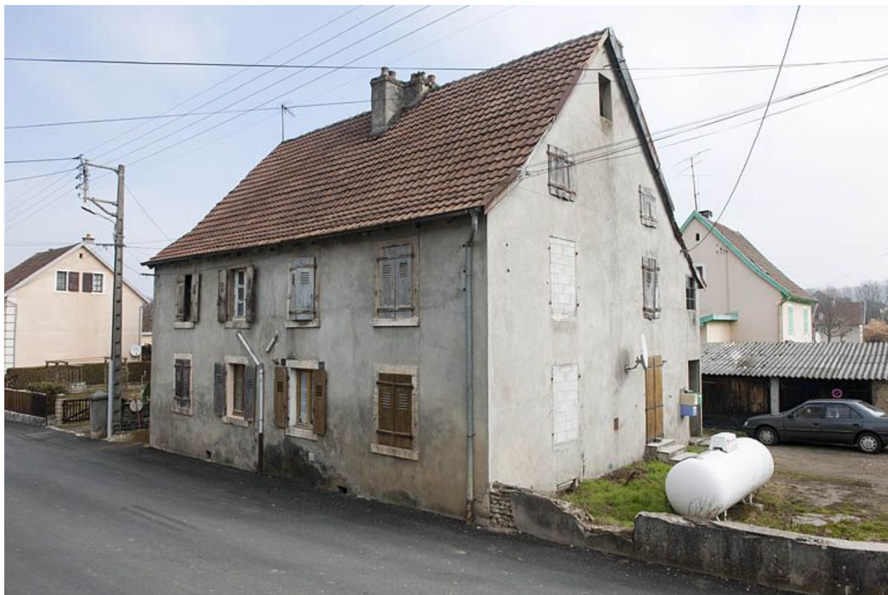
Immeuble à 4 logements dit "la Bastille".
