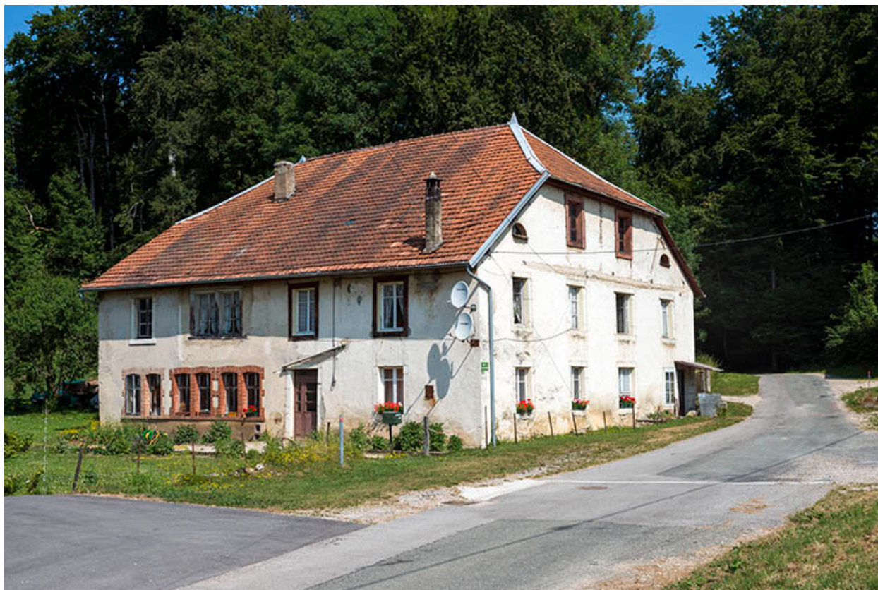
Façades antérieure et latérale droite.
