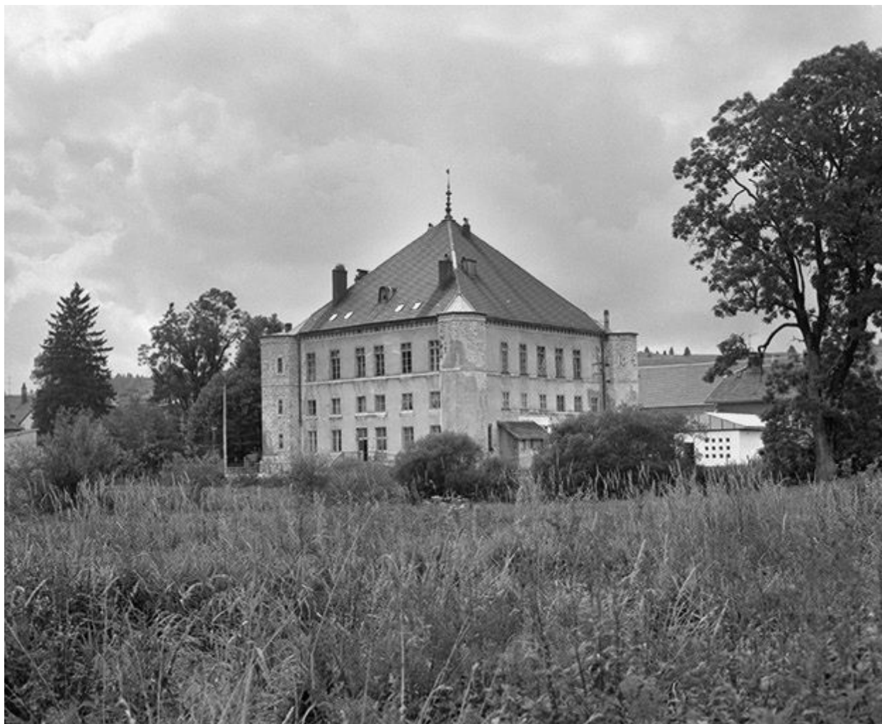
Façade postérieure et latérale gauche.
