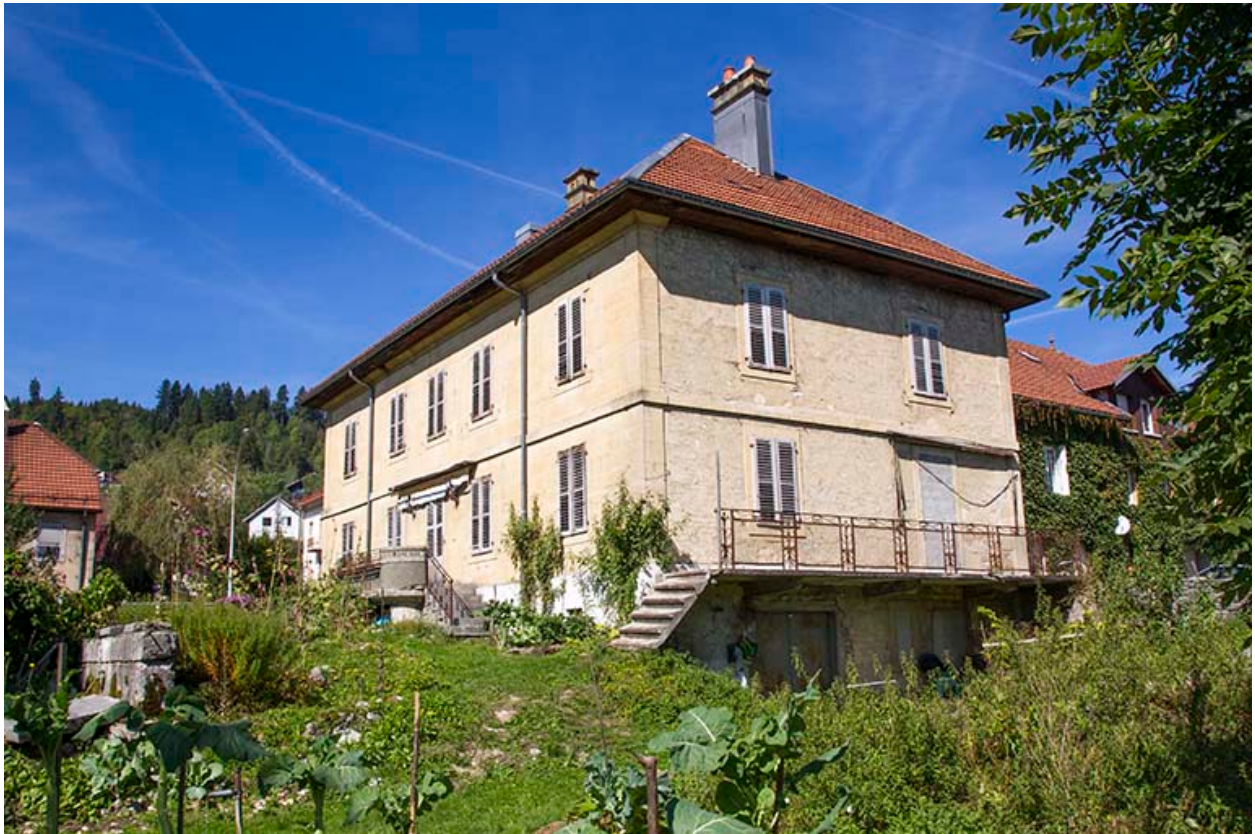
Corps sud : façades postérieure et latérale droite.
