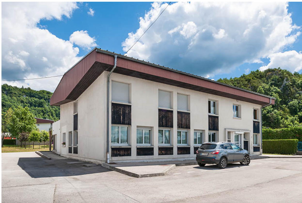
Administration, façade postérieure.
