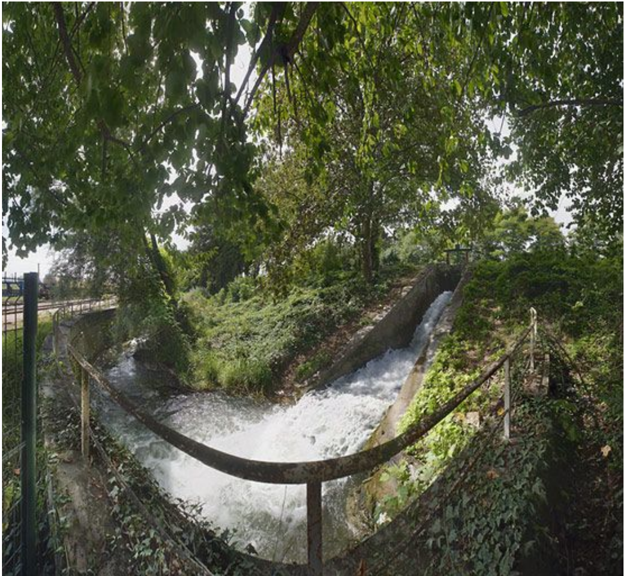
Vue d'ensemble de la rigole d'évacuation et de la vanne du déversoir de fond.
