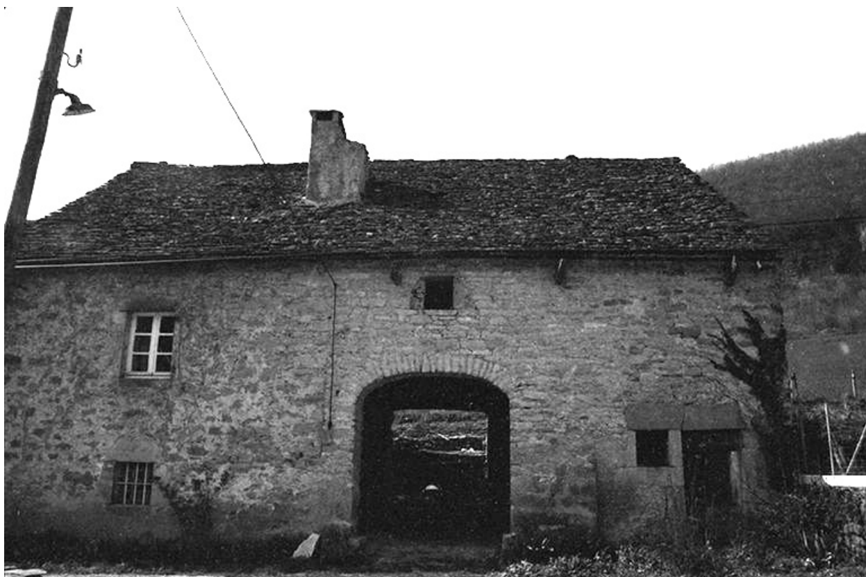
Ferme cadastrée 1964 AB 102 : façade postérieure. A noter le toit de laves.
