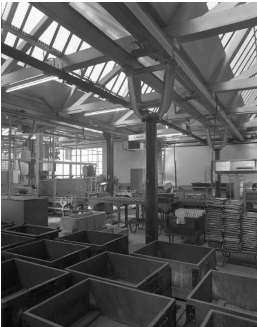
Atelier des culbuteurs. Charpente en bois.
