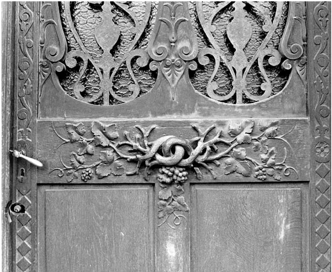
Détail de la porte d'entrée.
