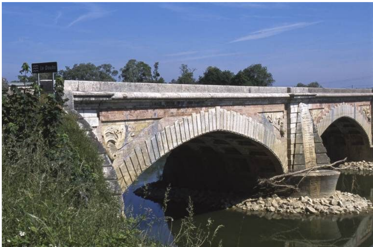
Détail d'une arche.
