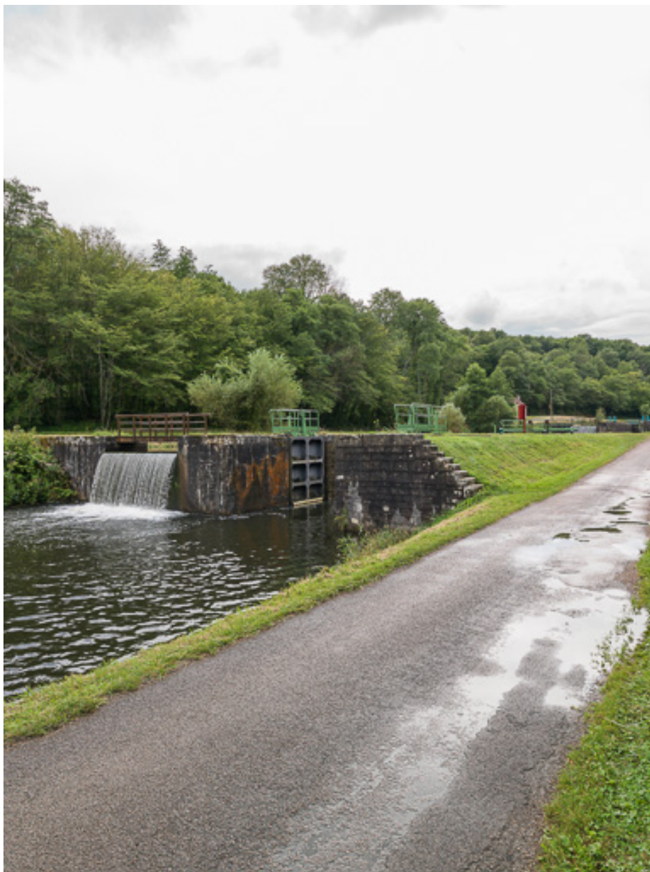
Vue du déversoir de superficie.
