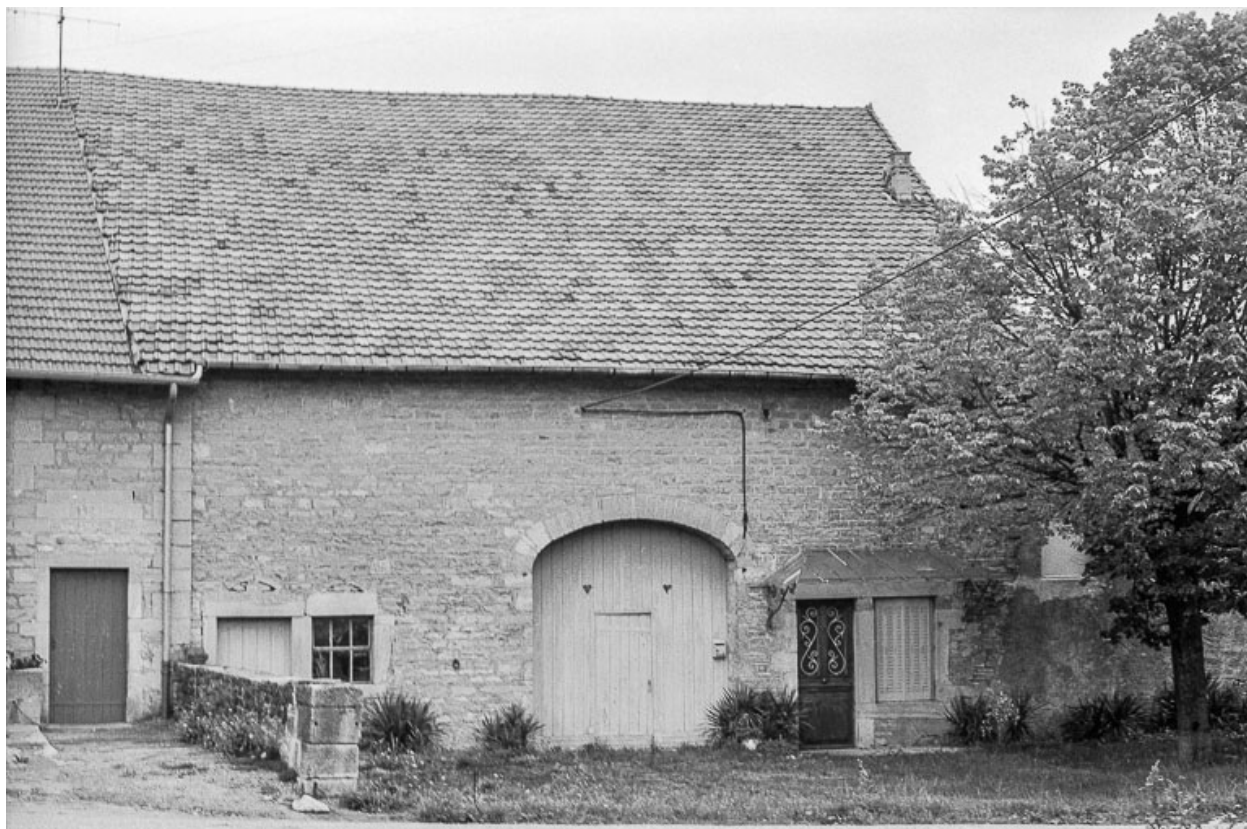
Ferme cadastrée B2 181 : façade antérieure.
