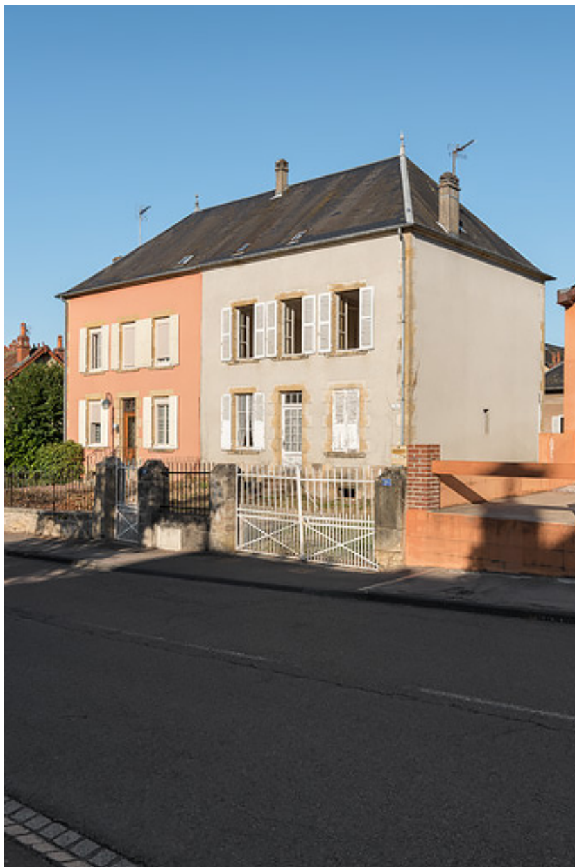
Façade sur l'actuelle avenue Eugène Collin.
