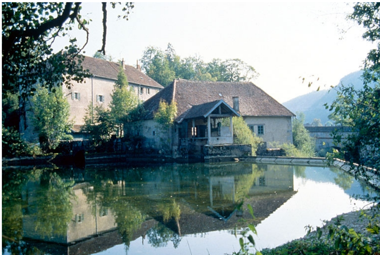
Barrage, retenue d'eau et scierie.
