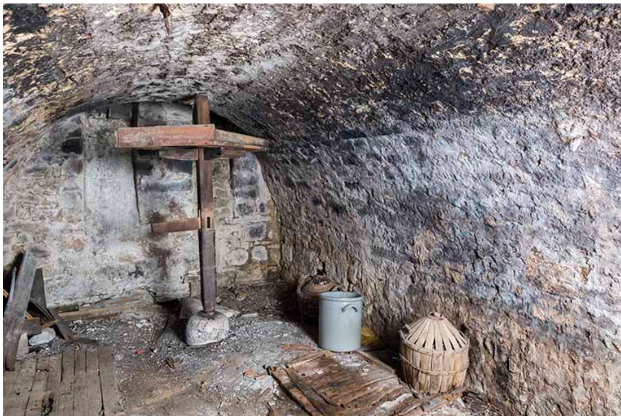
Intérieur de la cave en sous-sol.
