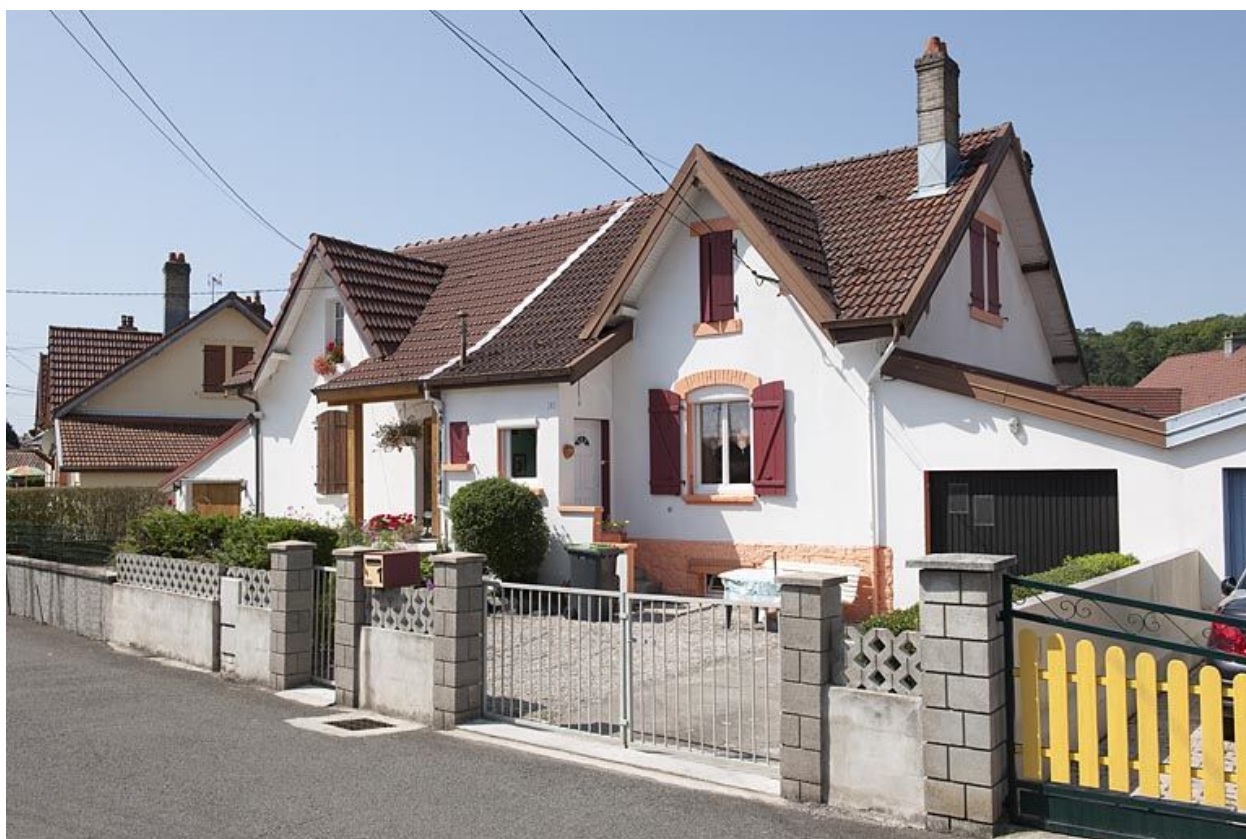
Maison jumelée rue des Lavandes.
