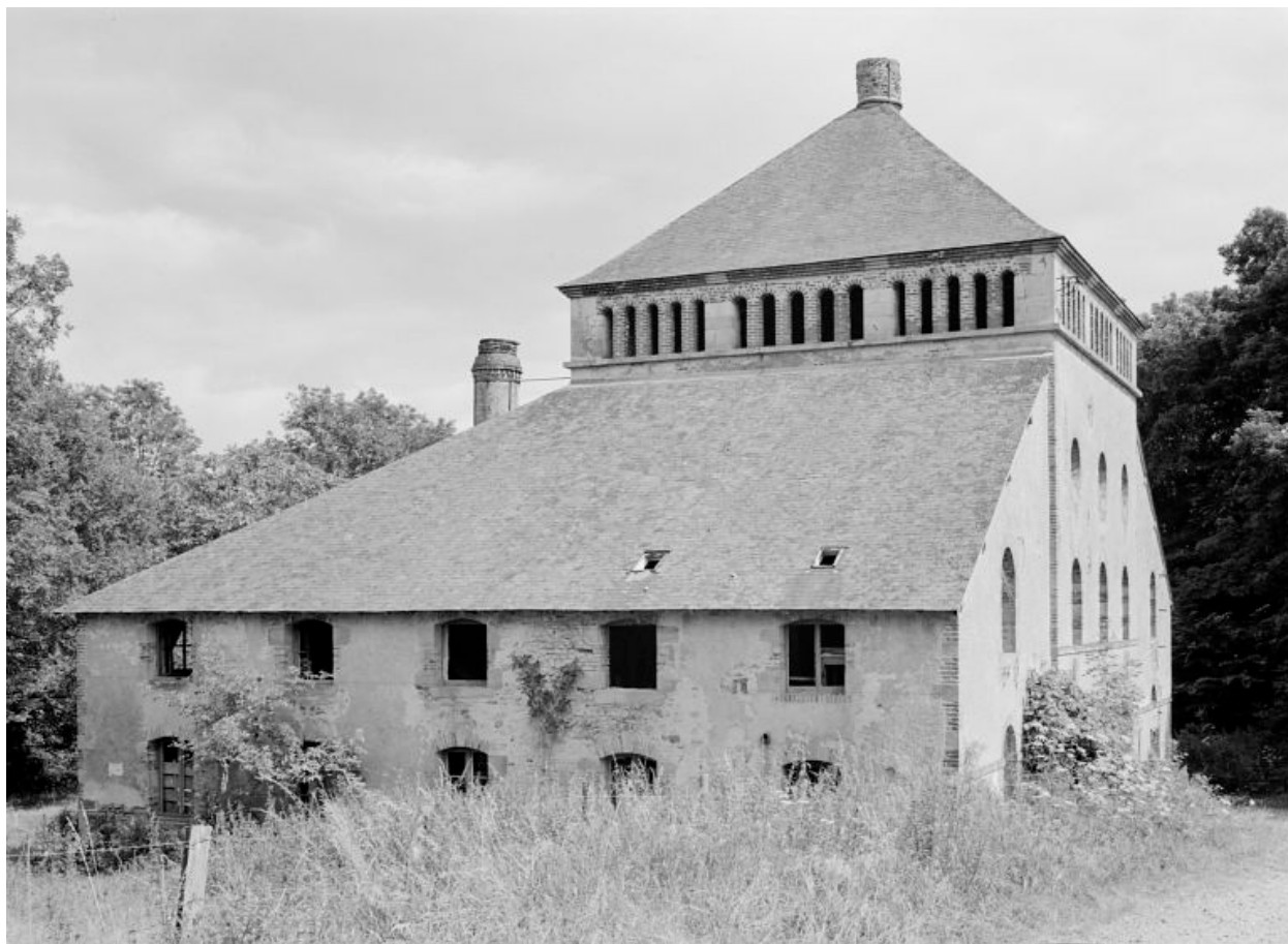
Vue depuis le nord-ouest, état en 1977.
