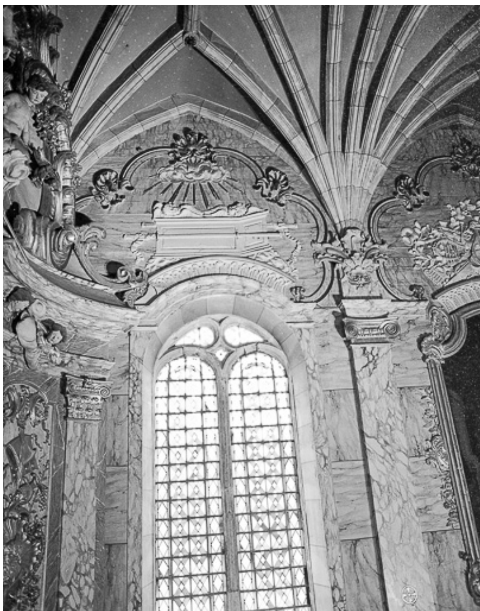
Mur droit, deuxième travée.
