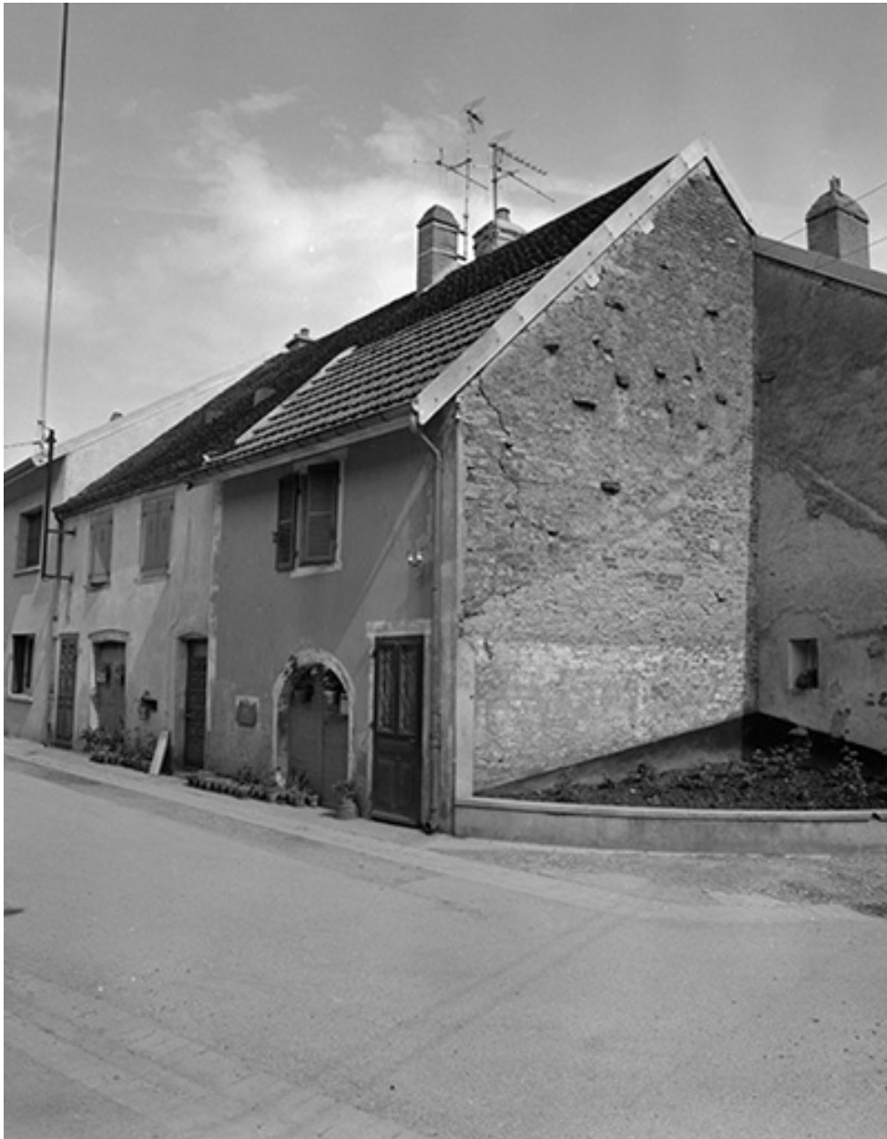
Façades antérieure et latérale droite.
