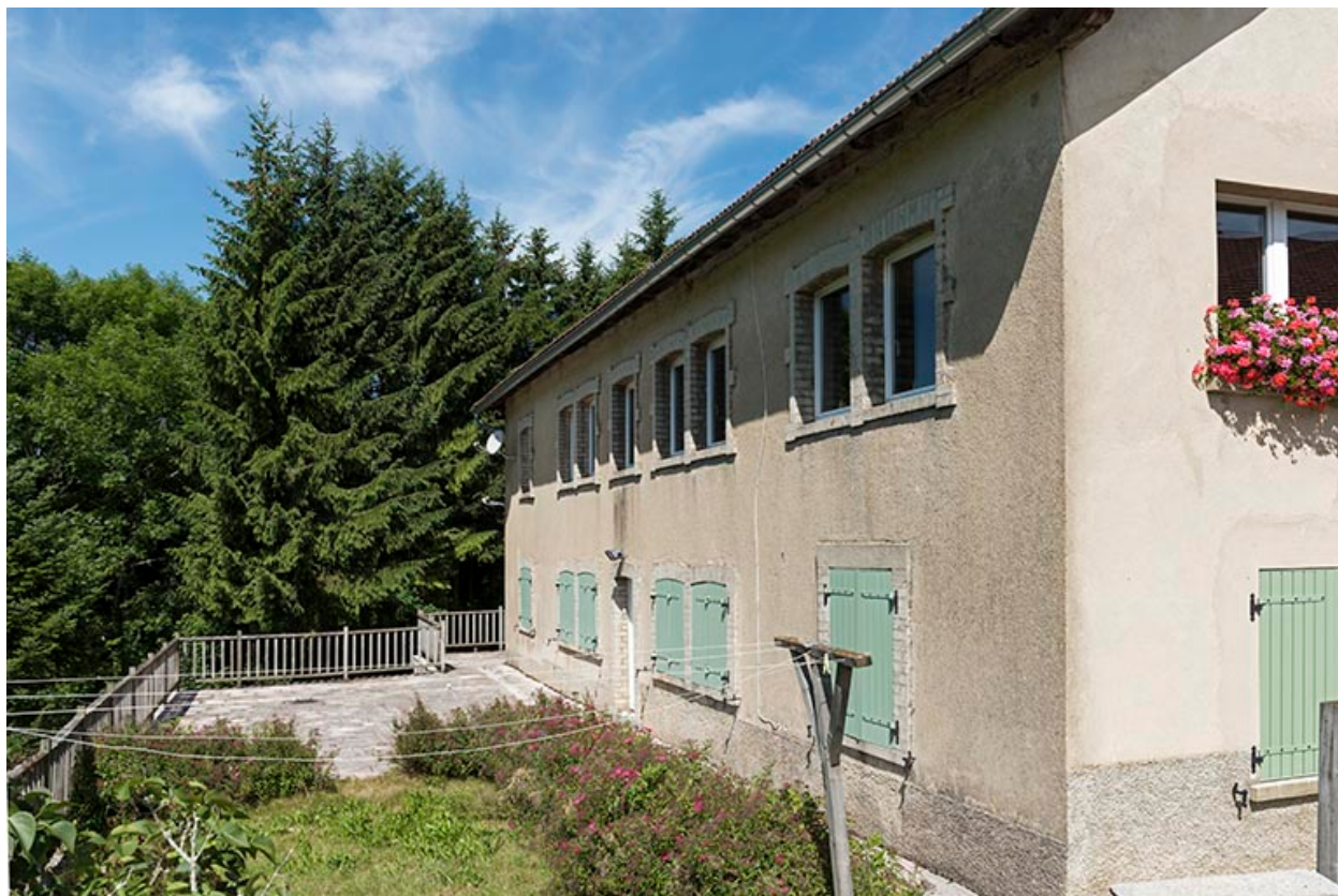
Façade sud, vue en enfilade.
